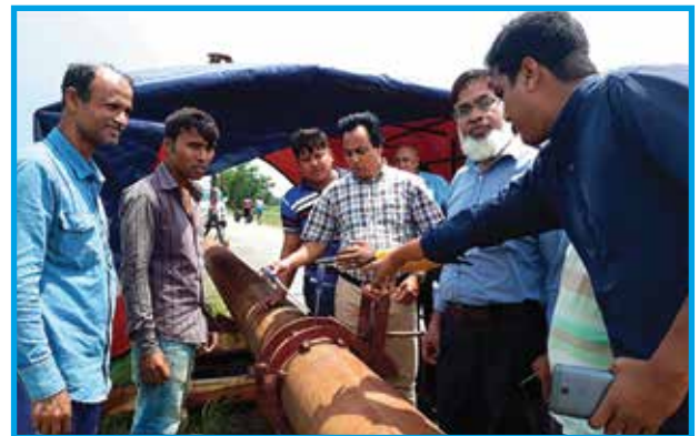
শ্রীহট্ট অর্থনৈতিক অঞ্চল, শেরপুর, মৌলভীবাজার-এ গ্যাস সরবরাহ প্রকল্পের পাইপলাইন স্থাপন কাজ
